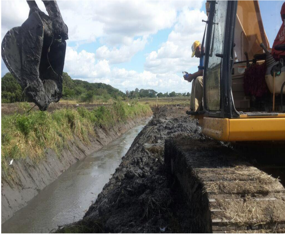
Limpieza de canal
