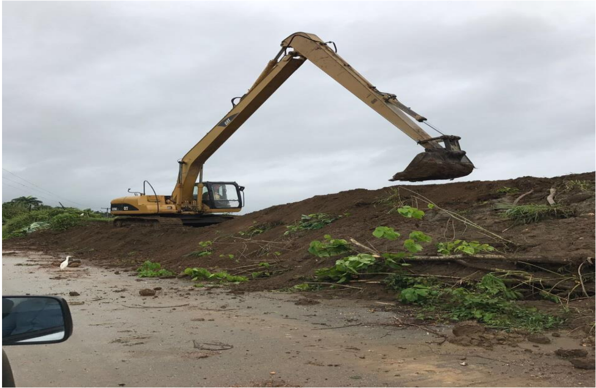
Construcción de muros para reforzamientos
