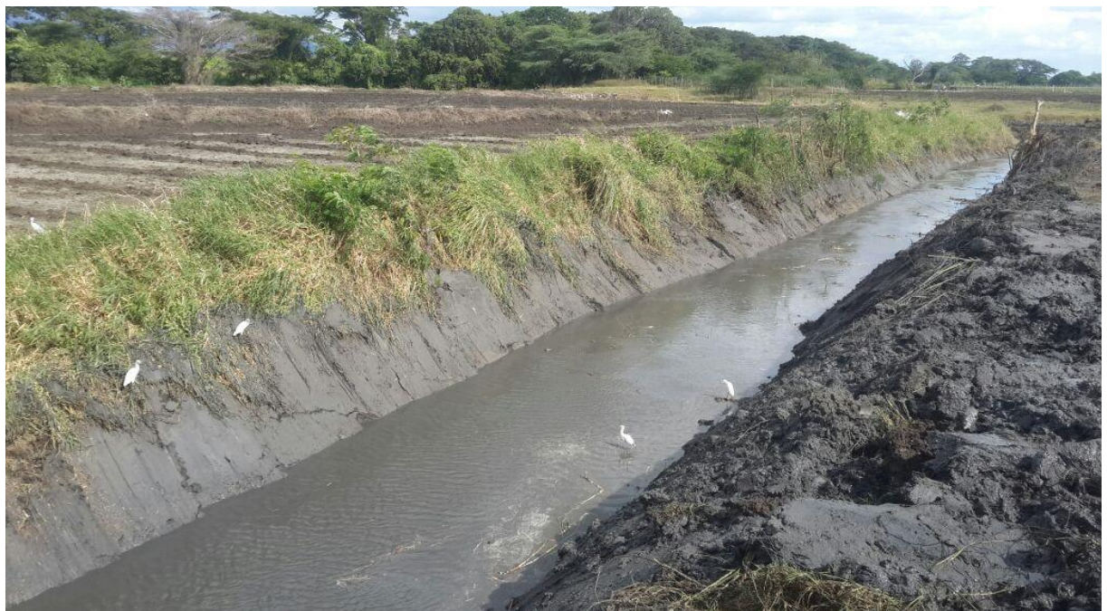
Limpieza de Dren
