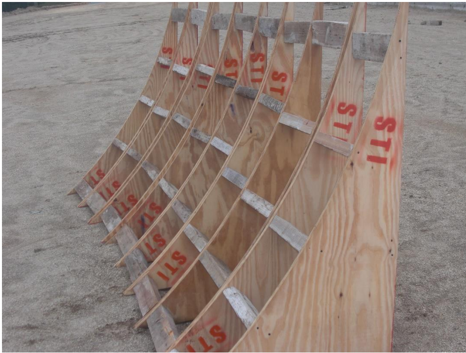
Moldes corona superior túnel de desvió
