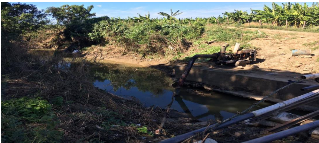
Construcción Puente canal colgante sector Juliana Jaramillo y Construcción Canaleta Metálica
