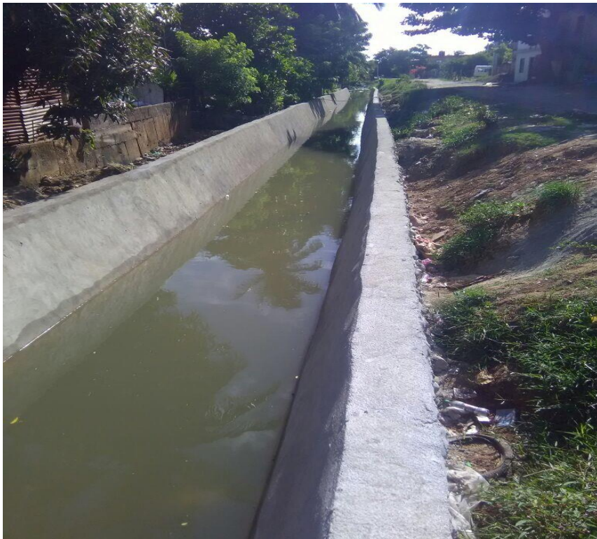
Limpieza de canal
