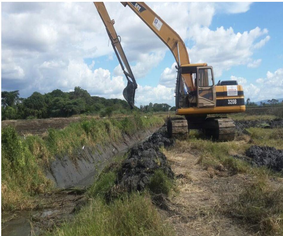
Limpieza de canal
