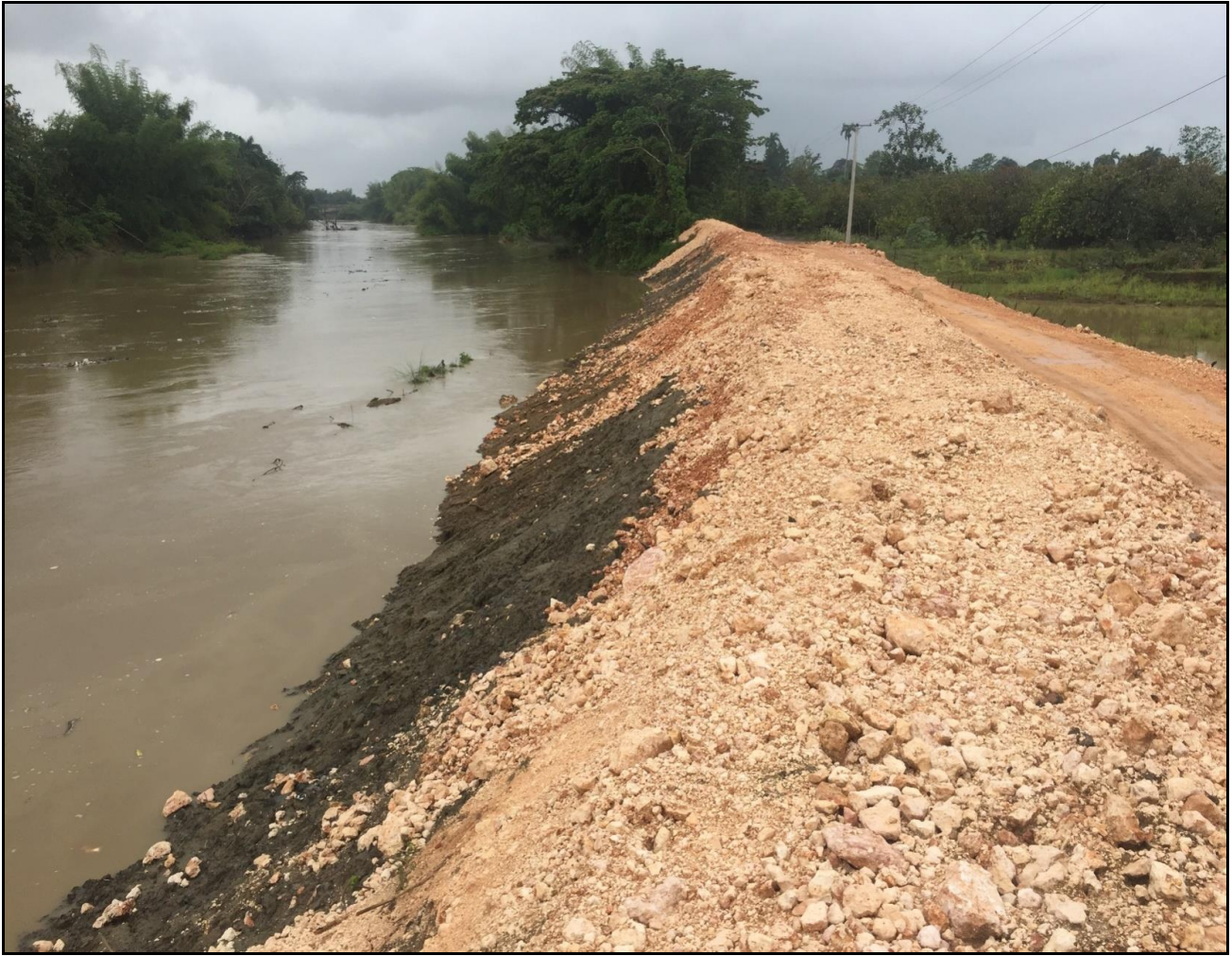
Muro en margen izquierda del Rio Yuna, Los Platanitos
