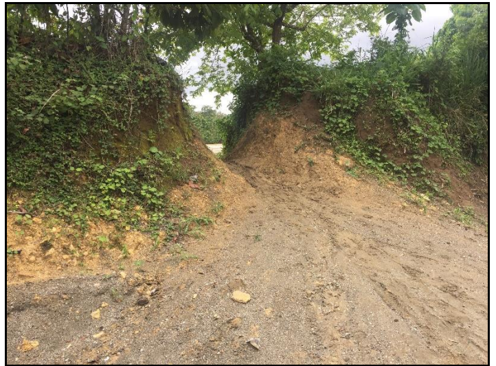
Dstrucción del muro en diversos tramos por los areneros
