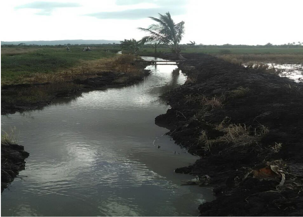
Limpieza de Drenaje
