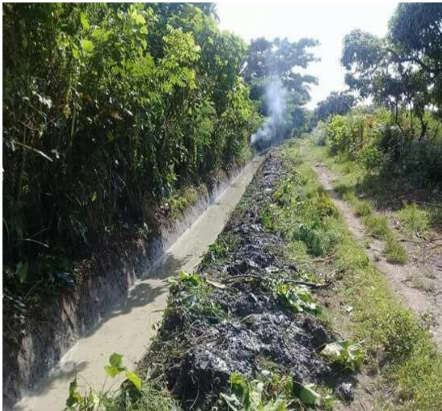
Limpieza de canal
