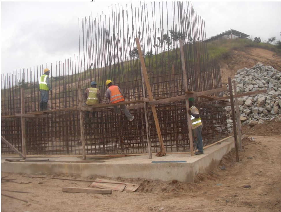
Encofrado y armado de muros obra de toma
