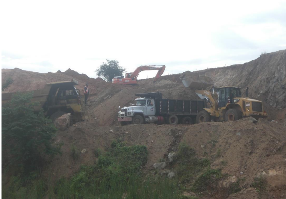
Equipos trabajando eje de la presa
