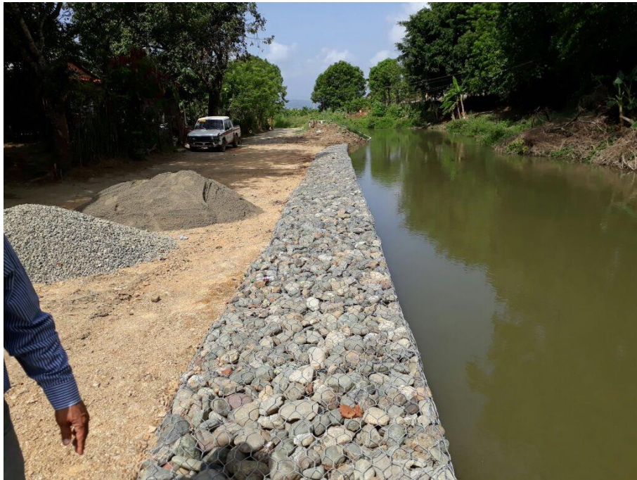
Construcción muro de gaviones
