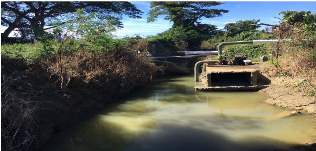
Construcción Puente canal colgante sector Juliana Jaramillo y Construcción Canaleta Metálica
