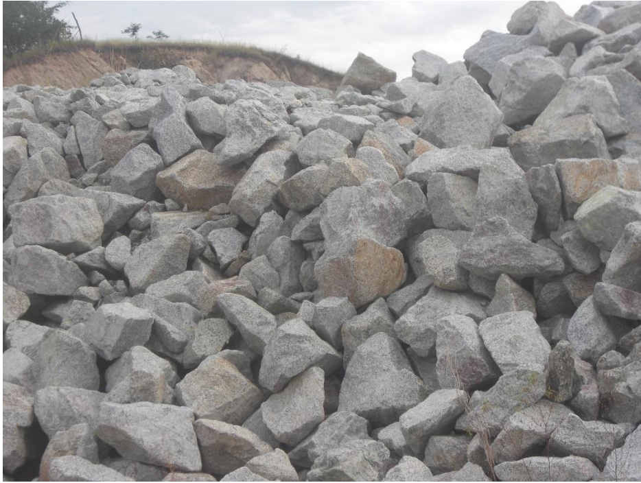
Acopio materia enrocamiento de la Presa
