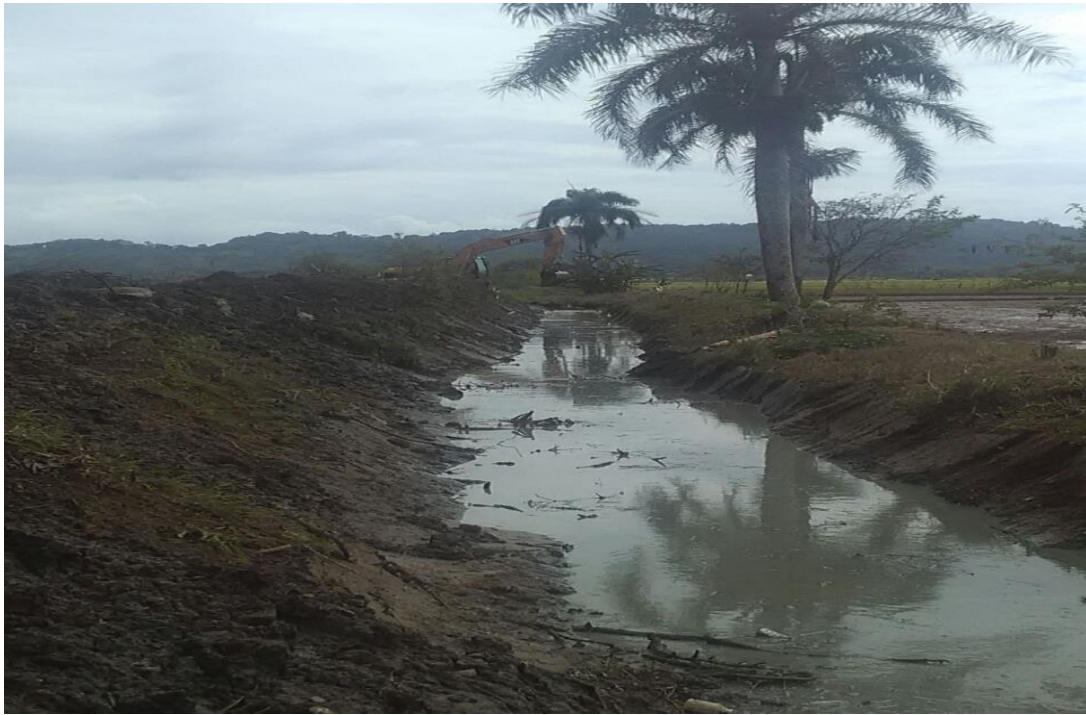
Limpieza de Canal
