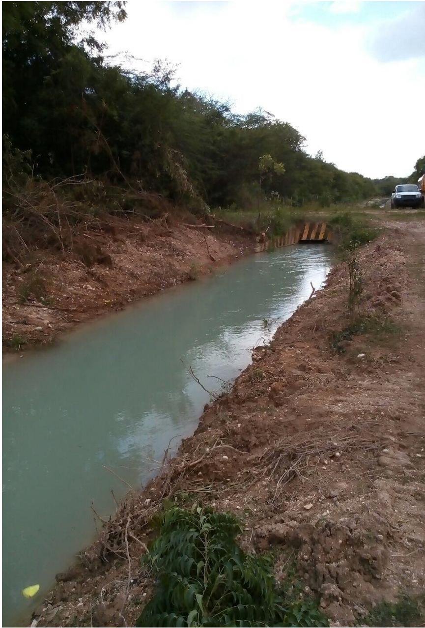
Limpieza de canal
