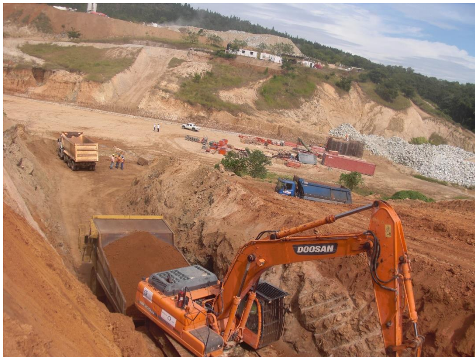
Equipos trabajando área del Proyecto.
