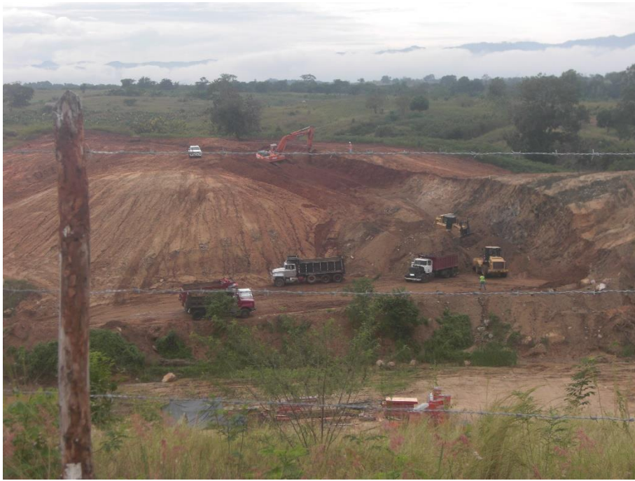
Excavaciones dentellón en el eje de la Presa
