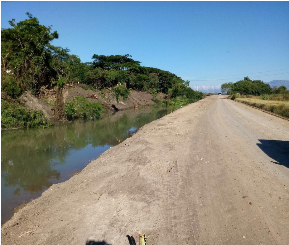
Limpieza de canal
