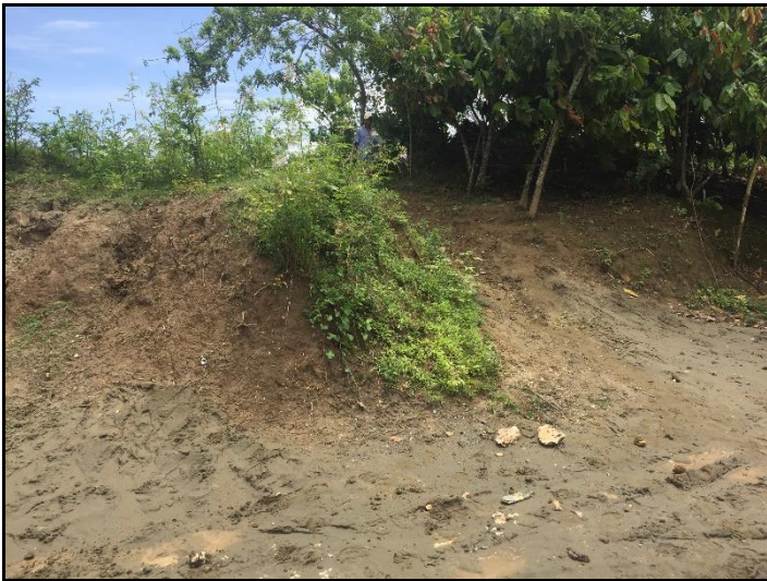
Dstrucción del muro en diversos tramos por los areneros
