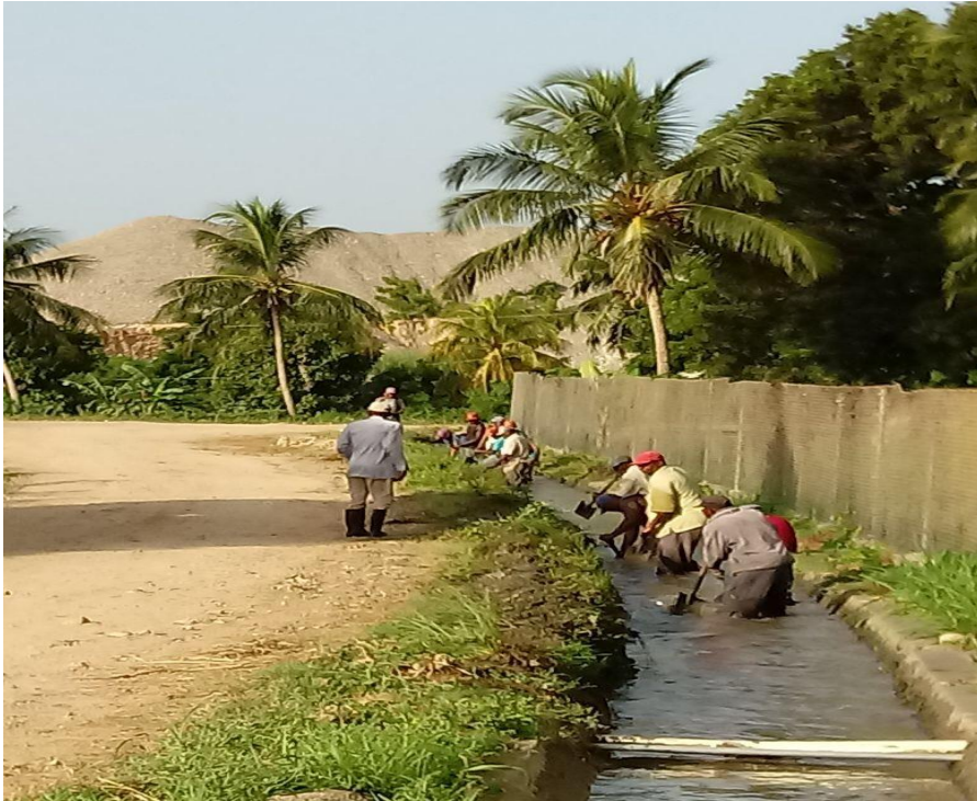
Limpieza de canal
