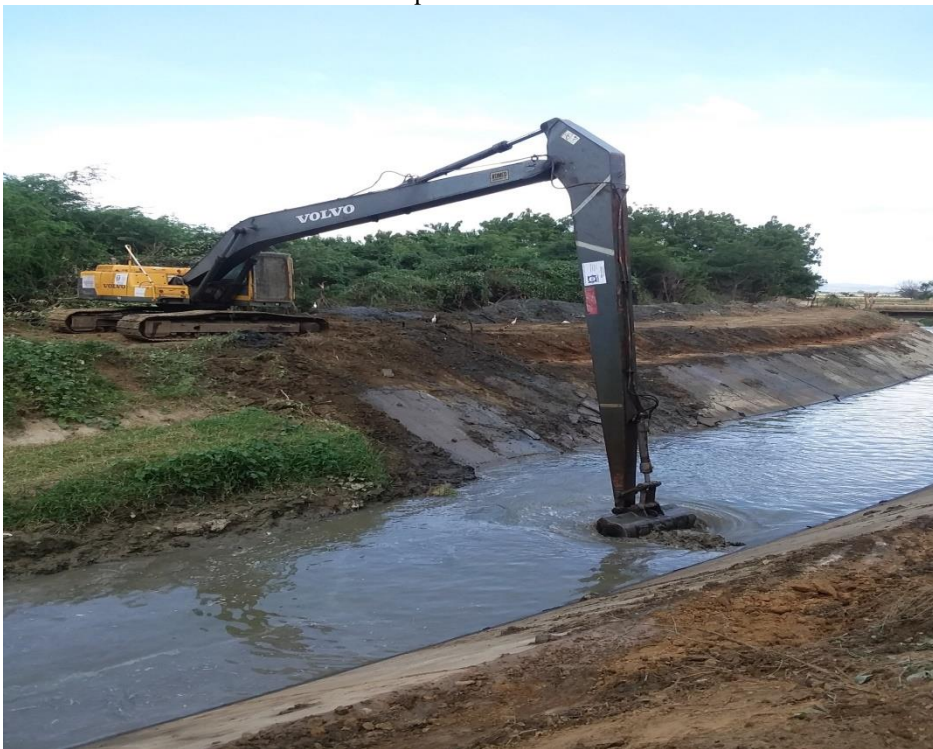
Limpieza de Canal
