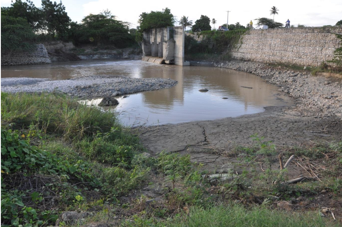
Adecuación río Yaque del Sur, Palo Alto Barahona 15-10-16
