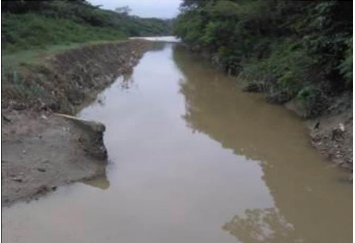
Limpieza de Canal
