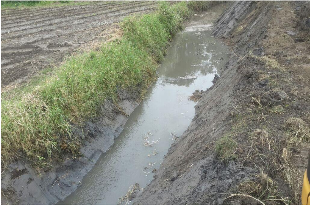
Limpieza de drenaje
