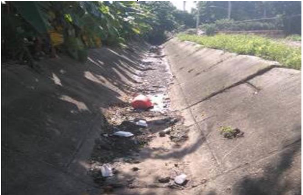
Limpieza de Canal
