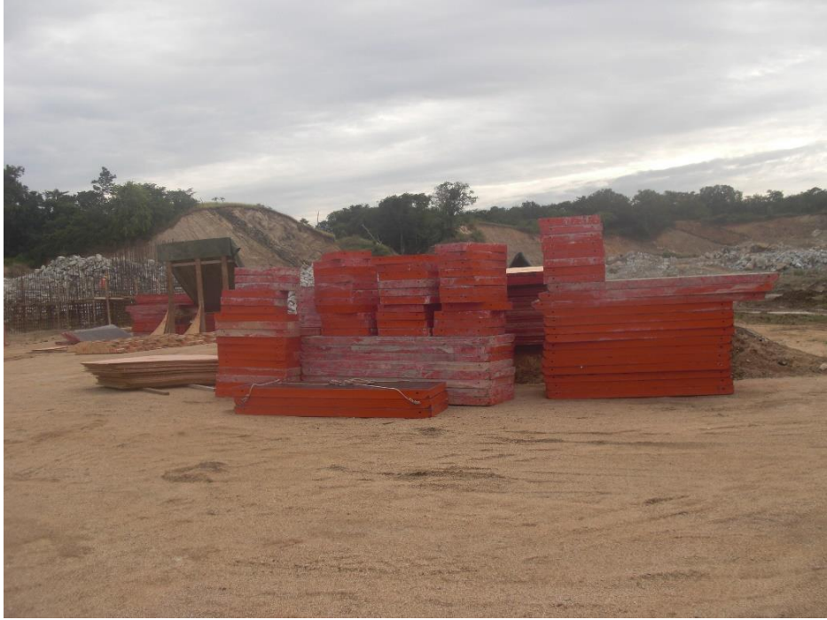
Moldes muros obra de toma
