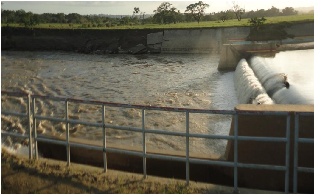
Revestimientos (md) río Yuna aguas abajo del dique inflable
