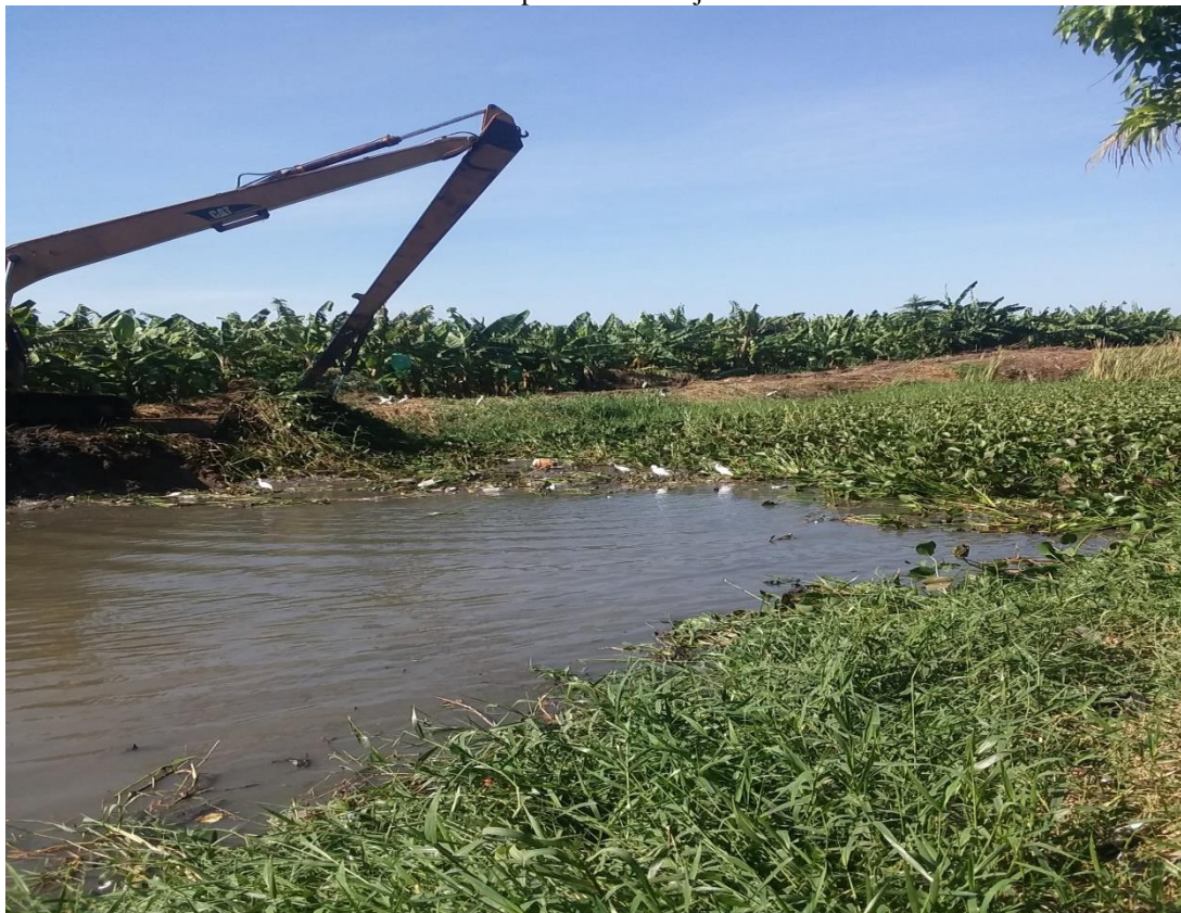
Limpieza de Drenaje
