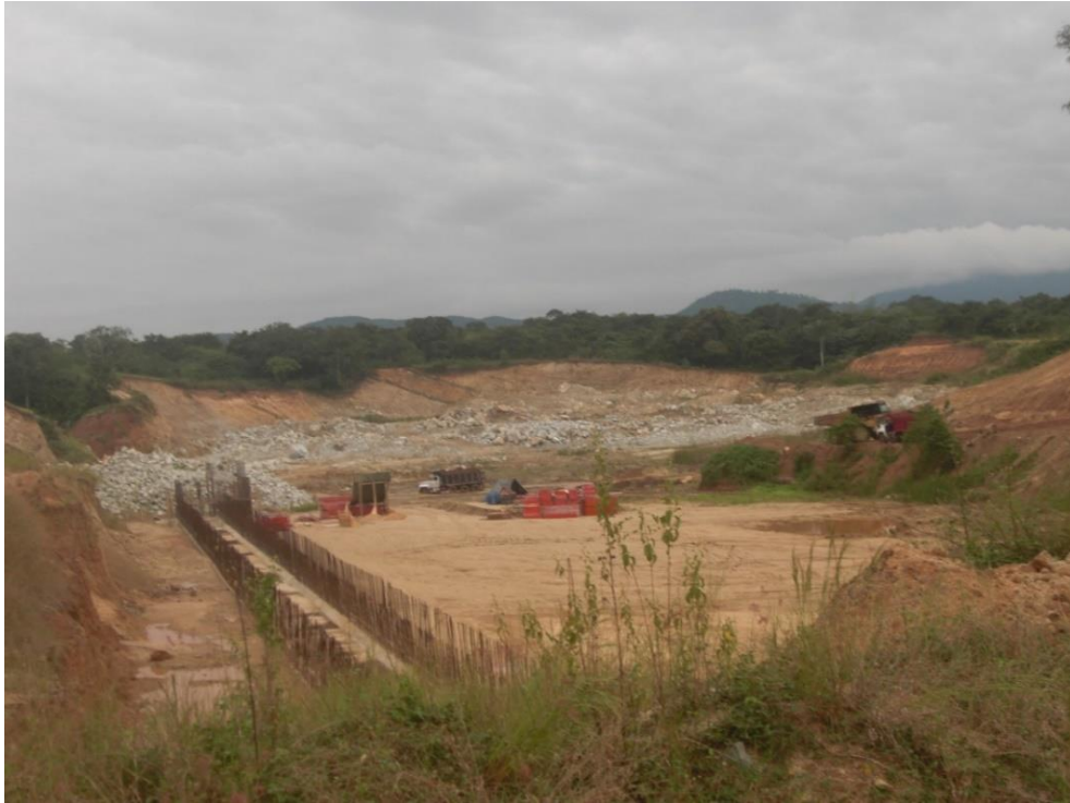
Vista del túnel de desvío y excavaciones rocas en el embalse
