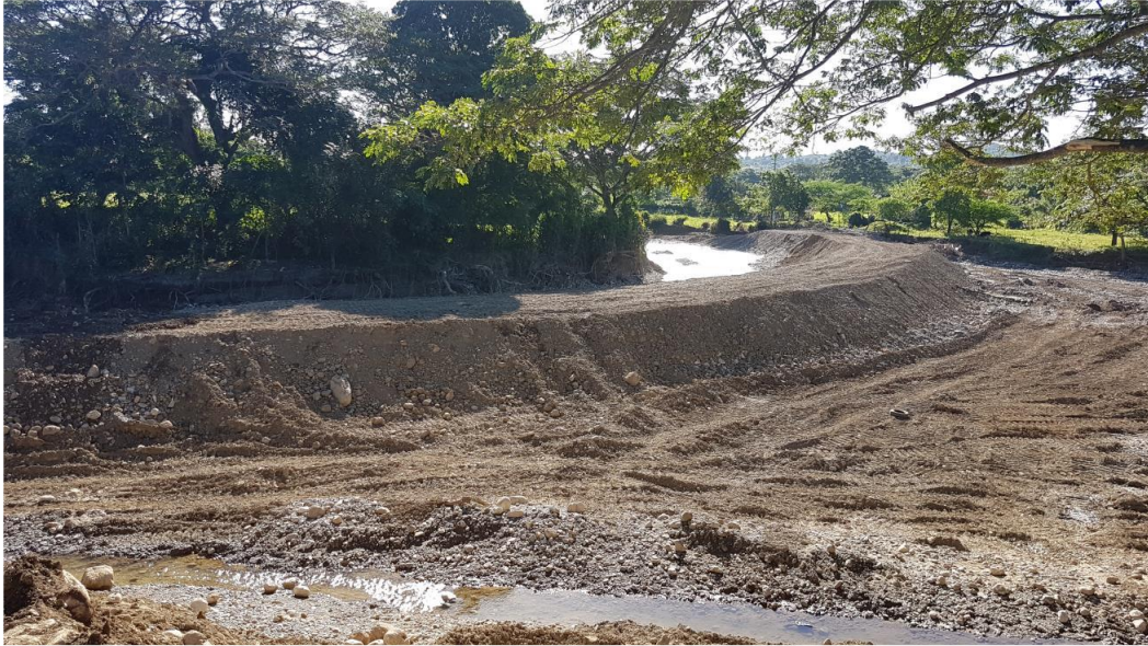
Muro del Río Unijica, Puerto Plata
