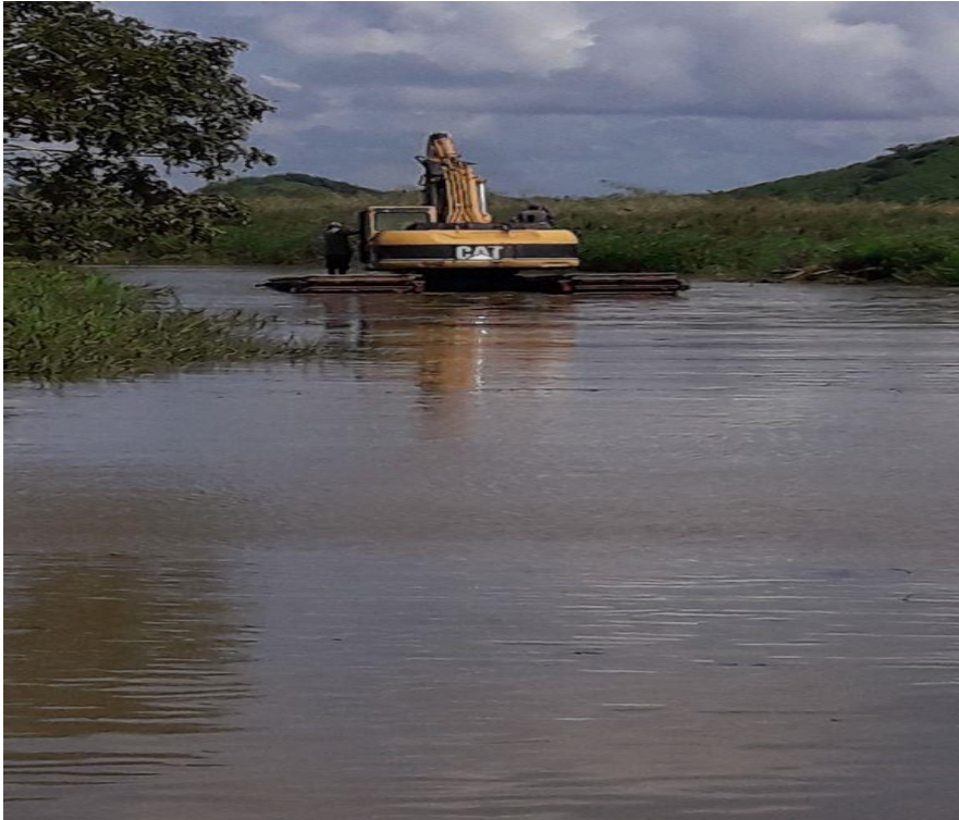
Limpieza de Laguna
