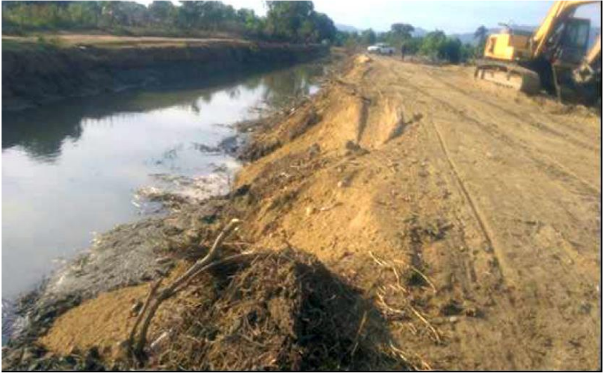
Limpieza de Dren y Berma
