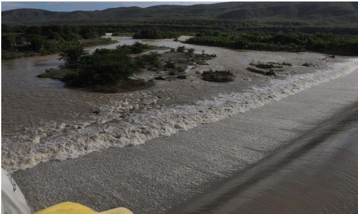
Dique Villarpando, Azua 06-10-16
