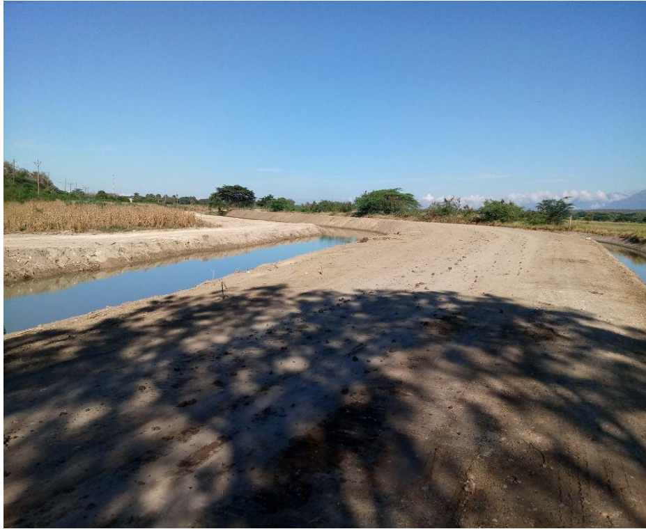
Limpieza de canal
