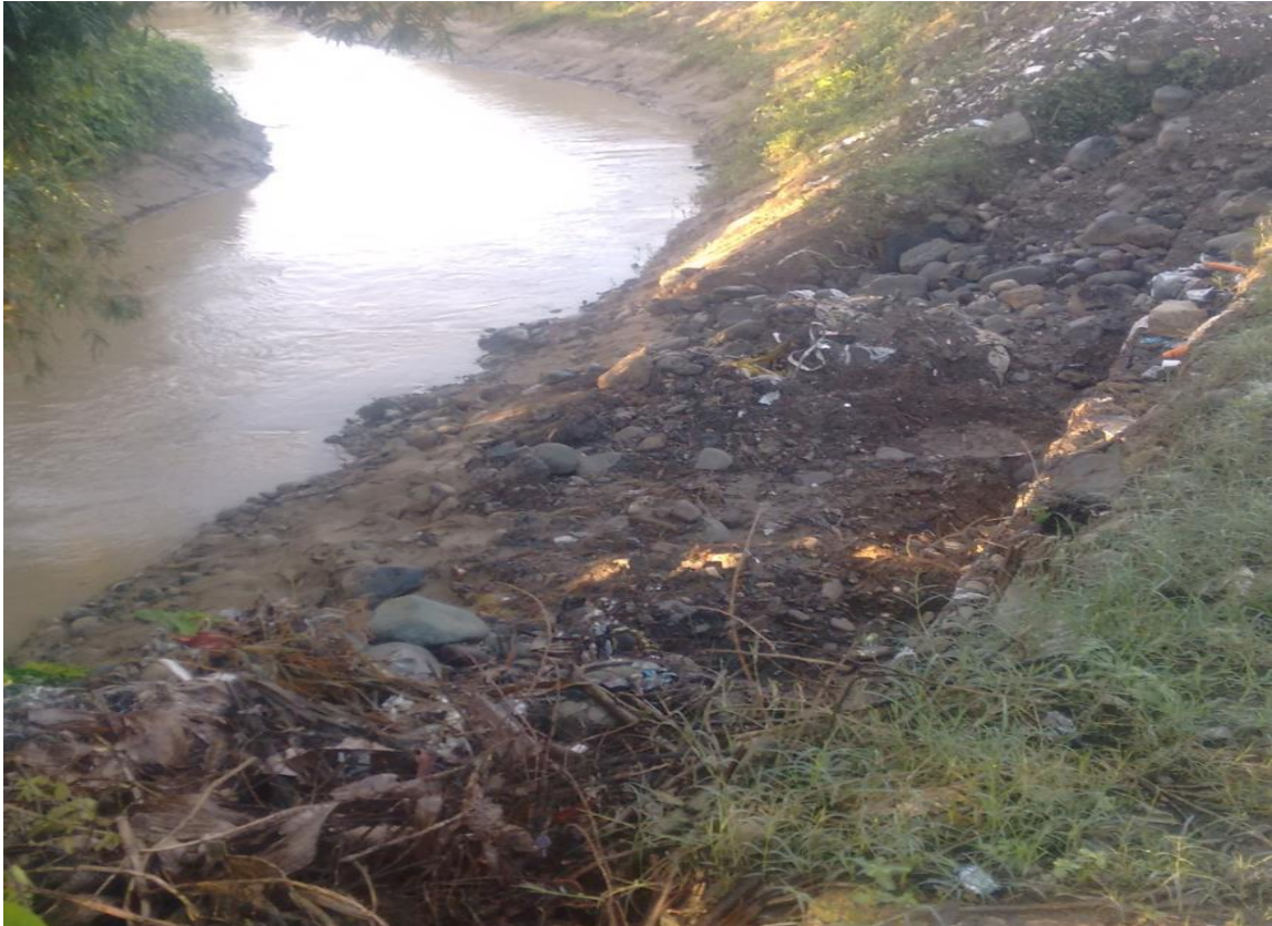
Limpieza de Canal
