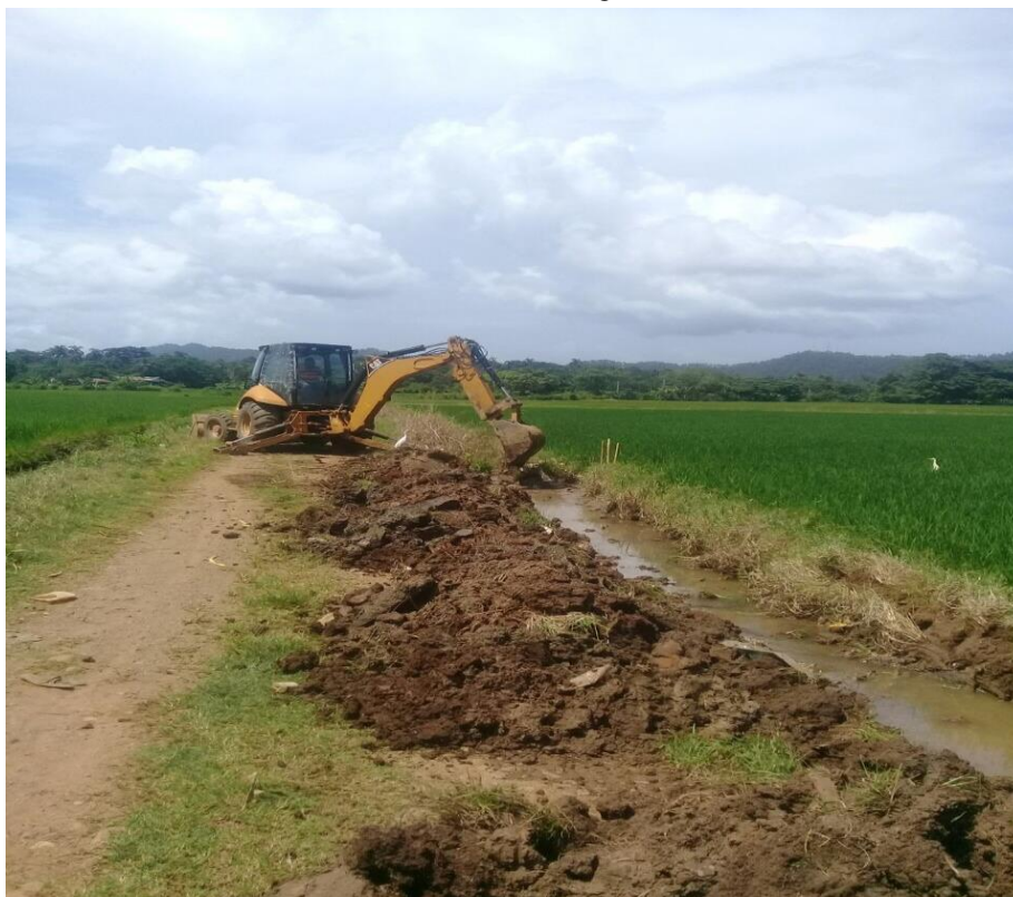
Limpieza de canal
