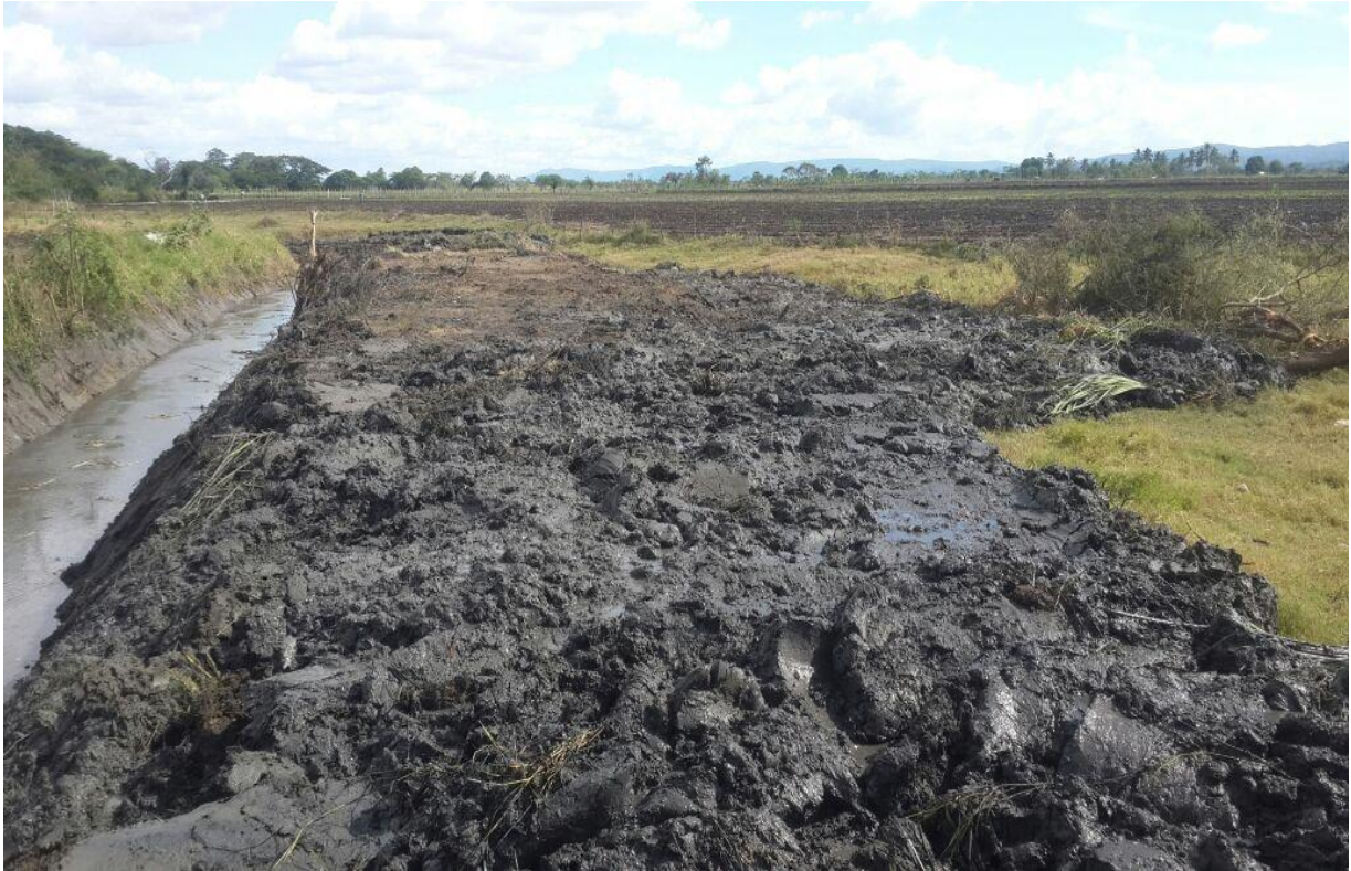
Limpieza de Dren
