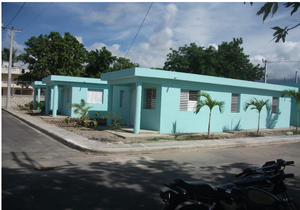
Pintura en Viviendas construidas con fondos de la hidroelectrica Los Toros
