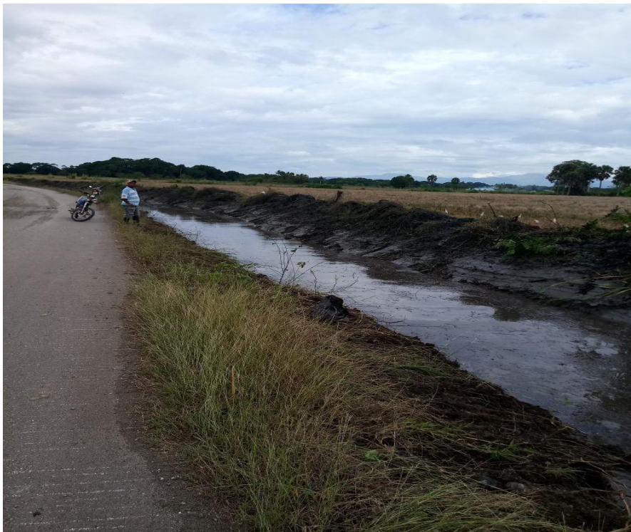
Limpieza de Canal
