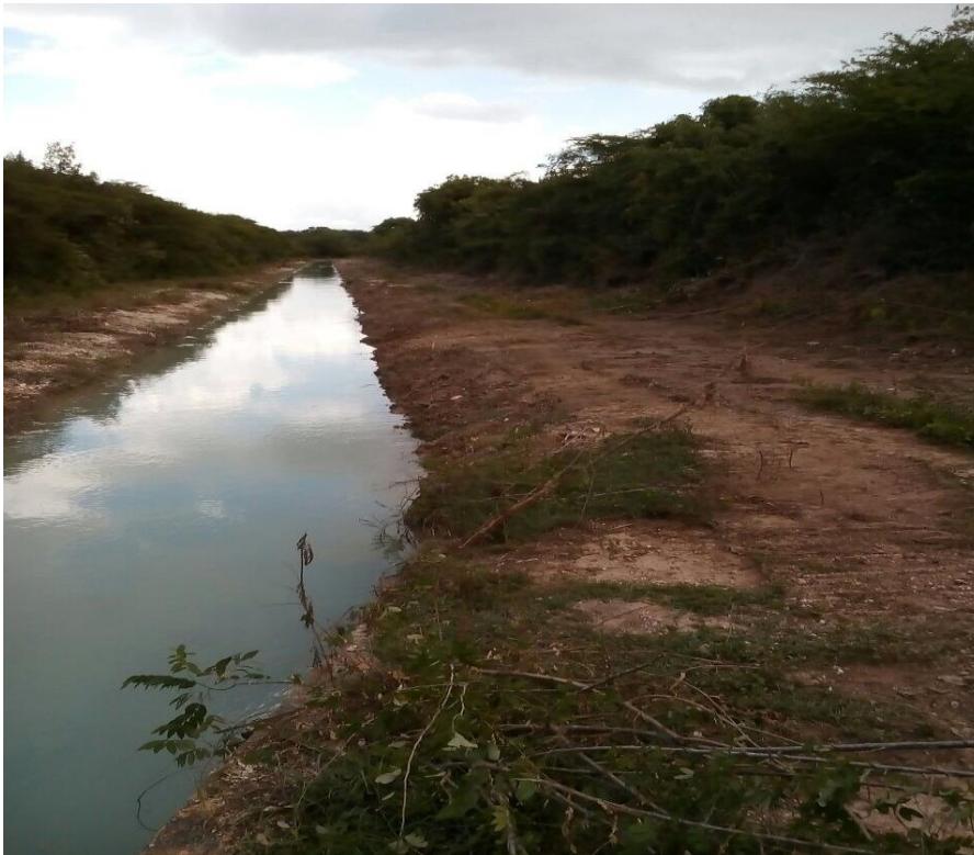
Limpieza de canal
