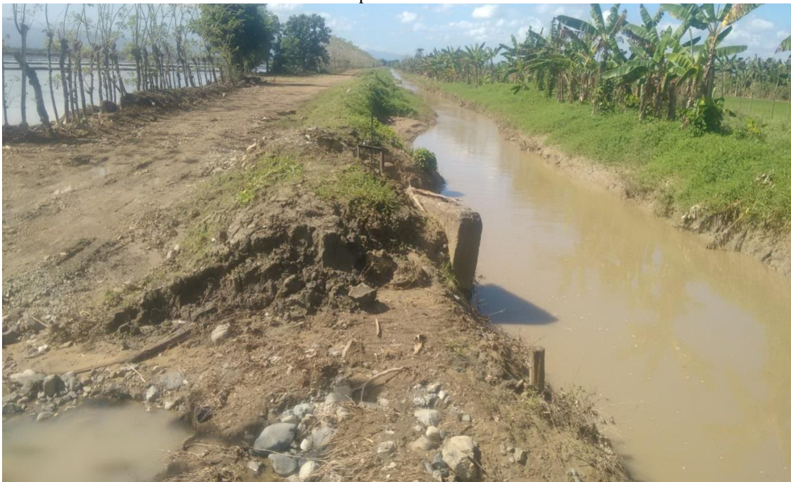
Limpieza de Canal
