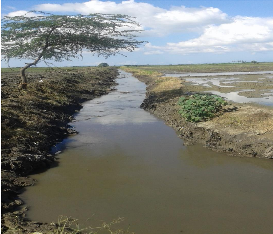
Limpieza de Canal
