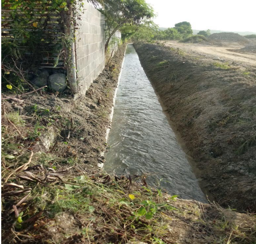
Limpieza de canal
