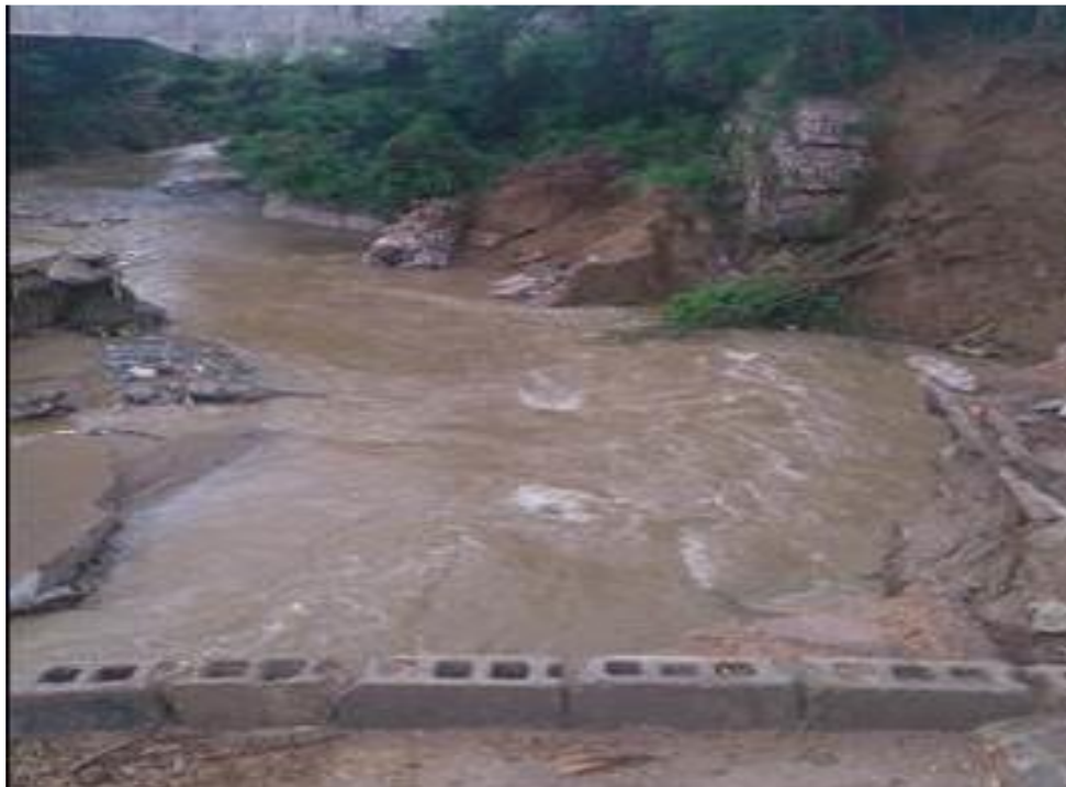
Construcción de muros de Gaviones revestido en la E8+000 para Protección flumen Canal UFE en el río Jacagua, Santiago
