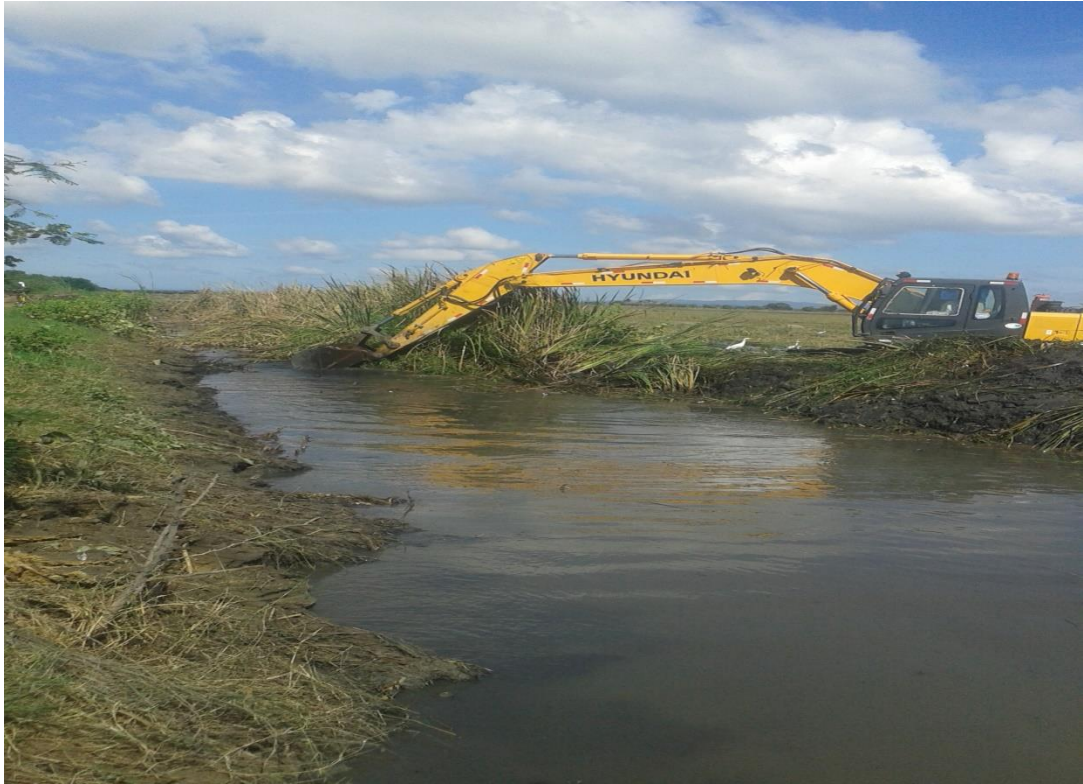
Limpieza de Drenaje
