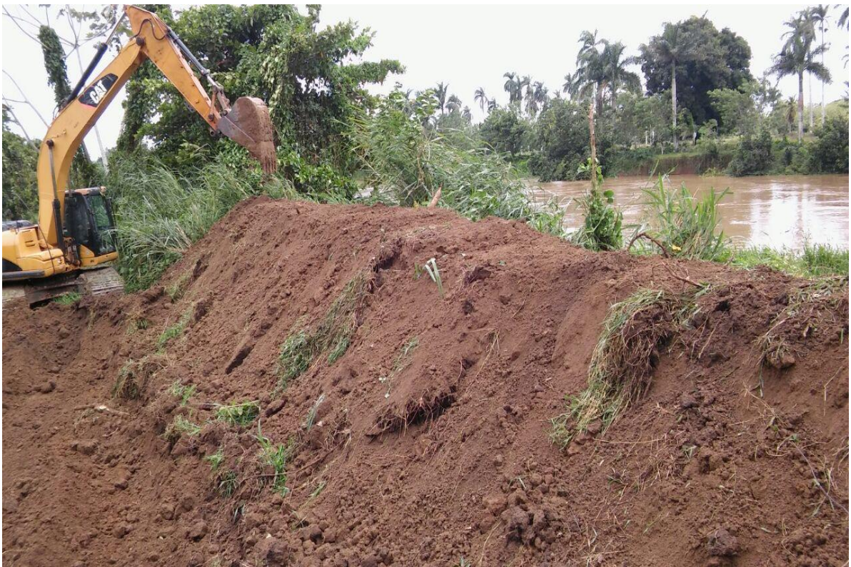
Construcción de muros para reforzamientos
