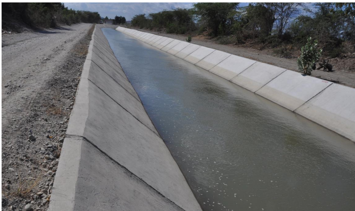
Vista de un tramo del canal Ysura, rehabilitado en su totalidad por el INDRHI, para posibilitar la irrigación de más de 290 mil tareas.
