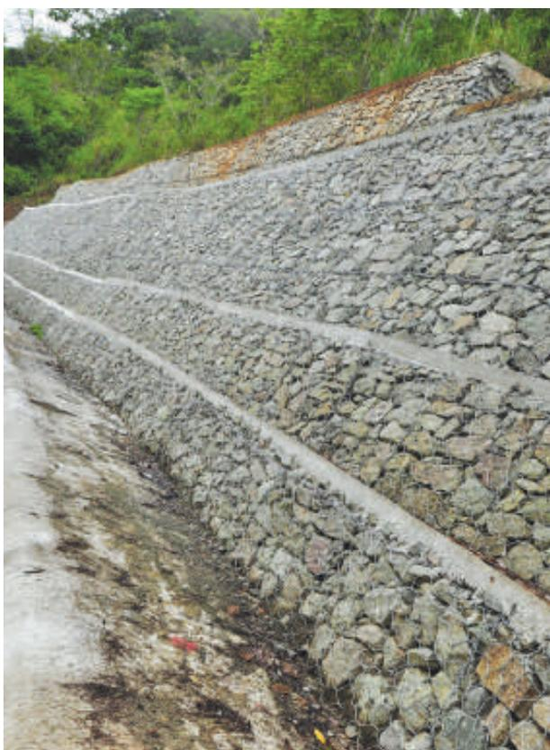
de la ladera de la margen izquierda aguas debajo de la presa, construcción de 1163 metros cúbicos de muros de gaviones para la estabilización de la ladera y mejoramiento del drenaje con una serie de obras desarrolladas en esa infraestructura.
