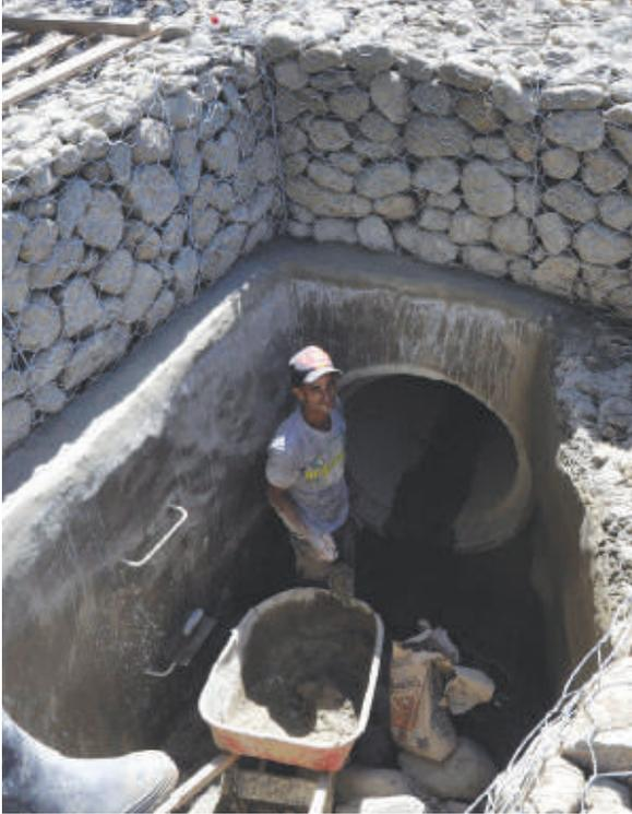
El proyecto de adecuación de El Riíto contempla la construcción de un conducto de hormigón armado en el trasvase I, además de una infraestructura similar de 1.3 kilómetros en el trasvase II.
